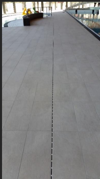
PISCINE DU LAC ST PARDOUX {87} CHABANNE & PARTENAIRES {69} DHALLUIN PENY ARCHITECTES {19}
